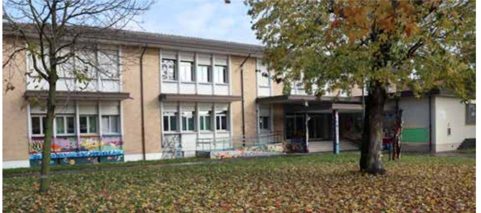
statici. Attraverso il confronto sul posto con le tavole di progetto, si è constatata la corrispondenza con il fabbricato realizzato. L'edificio dal punto di vista tipologico è classificabile come edificio intelaiato con travi e pilastri in c.a.. i tamponamenti esterni ed interni sono realizzati in laterizio e non risultano portanti. Gli interventi previsti per conseguire il miglioramento strutturale si possono così riassumere:
